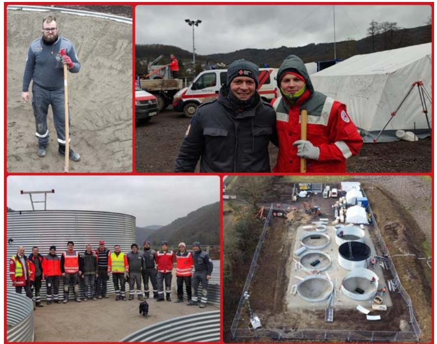
Aufbau der zweiten Kläranlage in Hönningen
