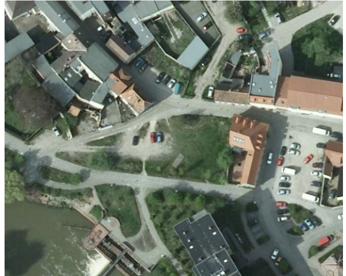
Freifläche vor Baubeginn – Vogelperspektive/2012
